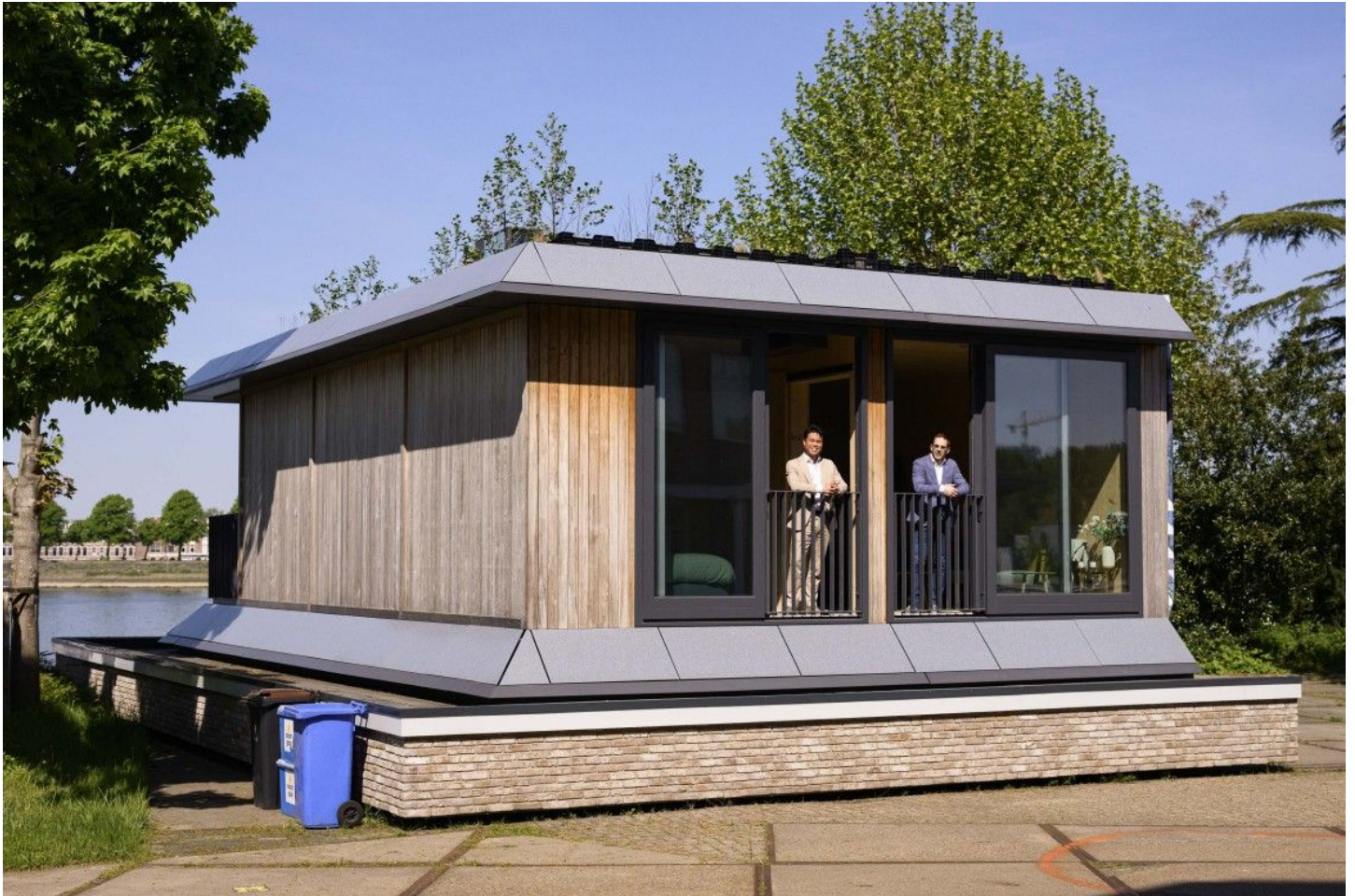
De VORM Optopper, extra woonruimte op bestaande bouw
